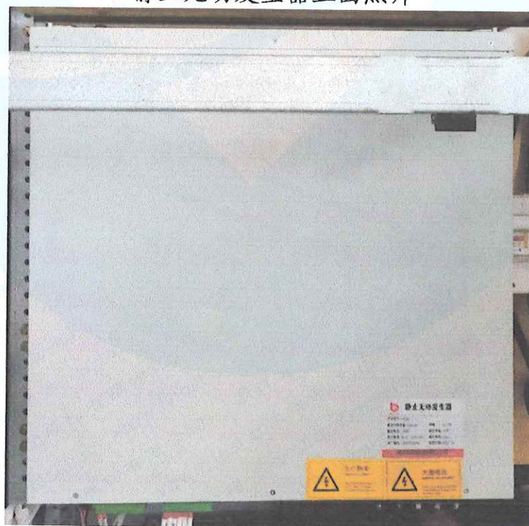
静止无功发生器正面照片
