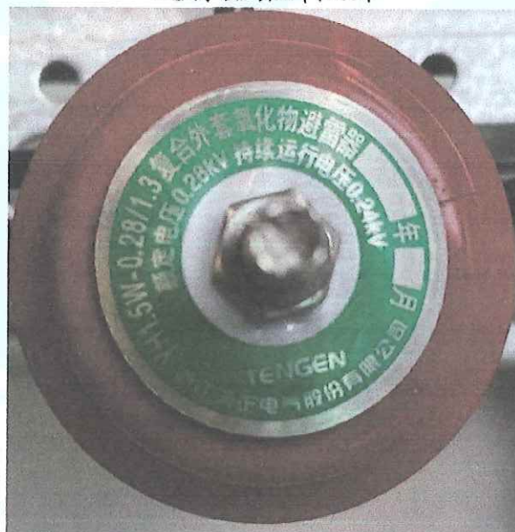
避雷器铭牌照片
