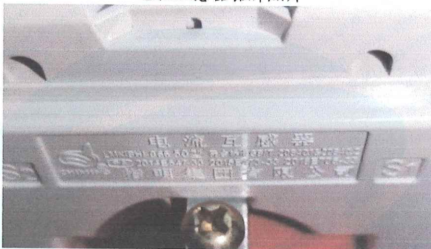
电流互感器铭牌照片
