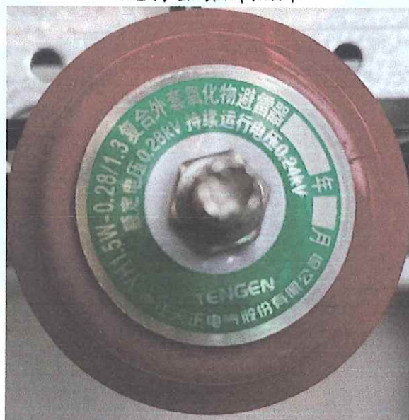
避雷器铭牌照片
