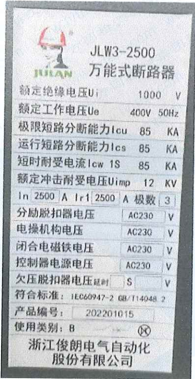
主进线开关铭牌照片
