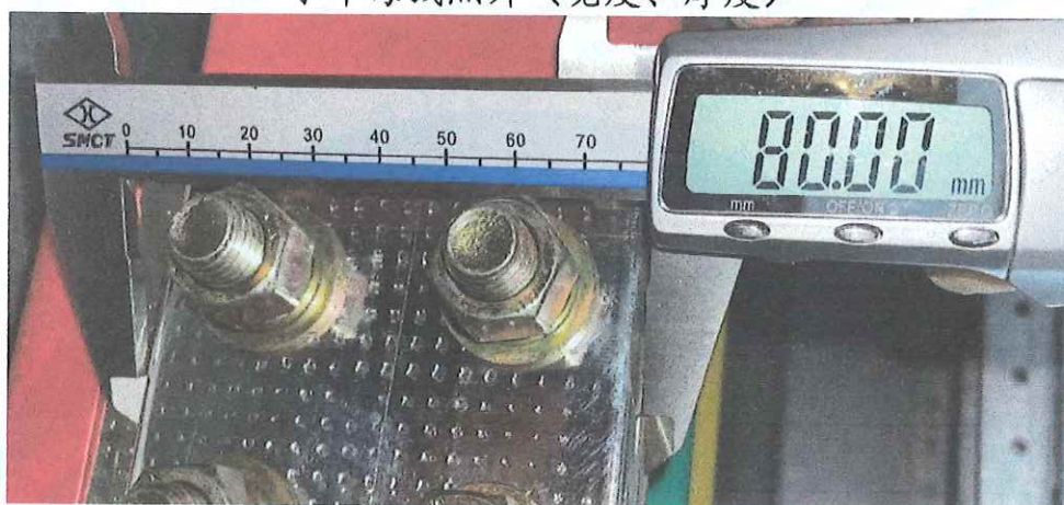
水平母线照片（宽度、厚度）
